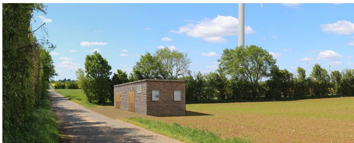
Intégration paysagère du poste de livraison
