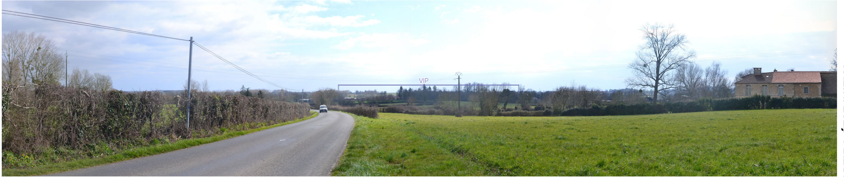
Photo 43 : Depuis la sortie du hameau de Payré-sur-Vendée, le VIP apparait filtré par la trame végétale
