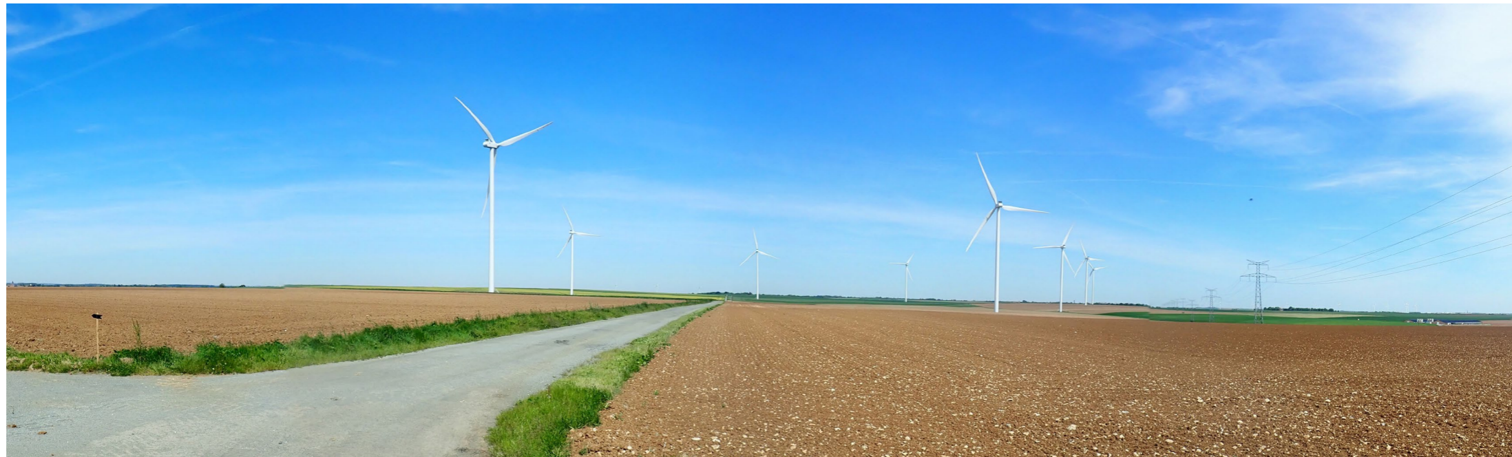
Photo 11 : Parc éolien IEL 28
