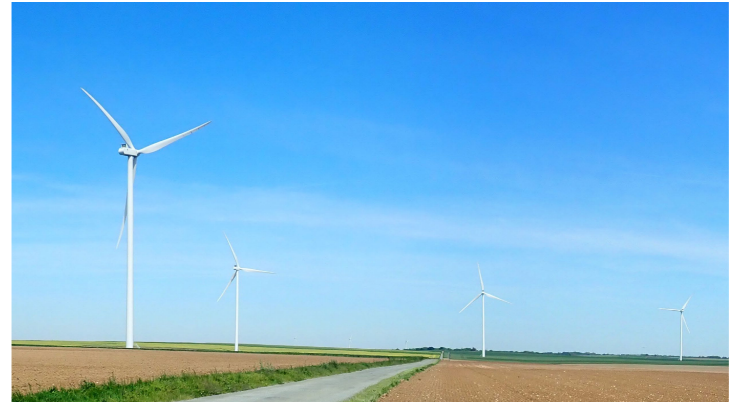
Photo 35 : Parc éolien IEL 28
