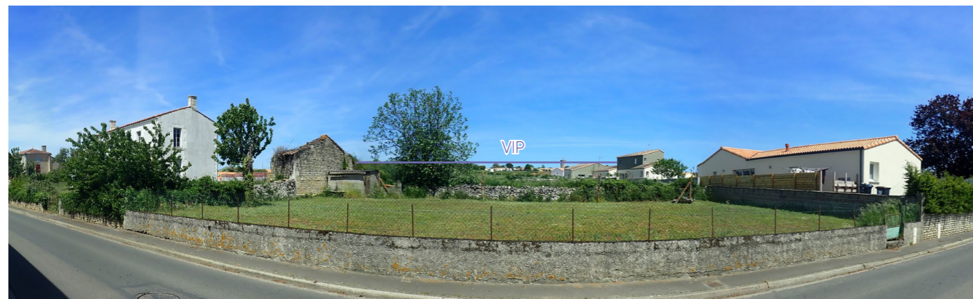
Photo 77 : Depuis la RD68A, le VIP est visible mais le monument est masqué par la trame bâtie
