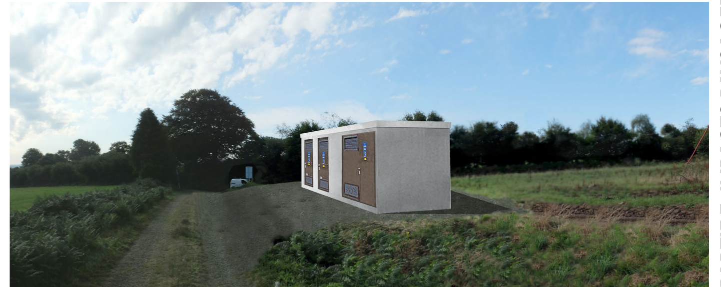
Photo 82 : Exemple de PDL finition béton peint
