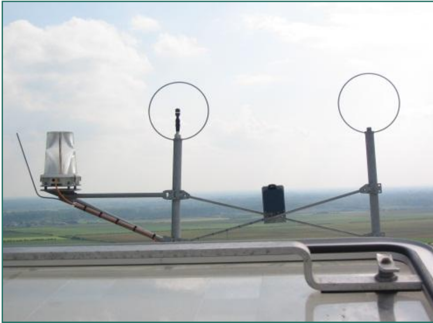
Figure 13 : Photographie d'un exemple de balisage aéronautique
